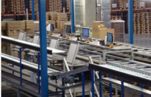
Plateforme d'injection manuelle
